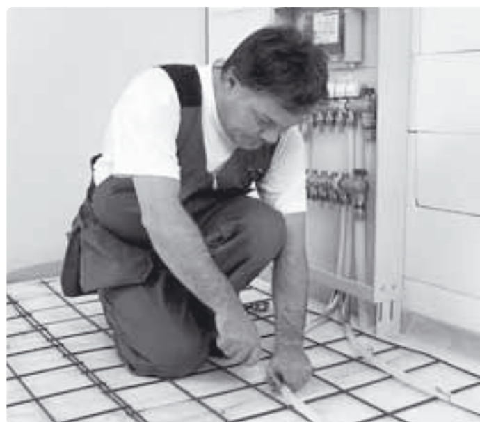
Golvvärmerör najas mot armeringsjärn
